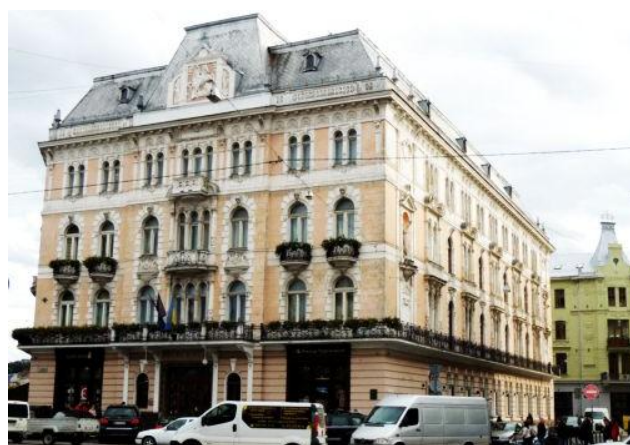
Hotel George. Tu w 1925 mieszkał tenor Jan Kiepura, który 15 stycznia wystąpił w Teatrze Wielkim w roli Fausta. Z balkonu na I piętrze dawał publiczne koncerty.
