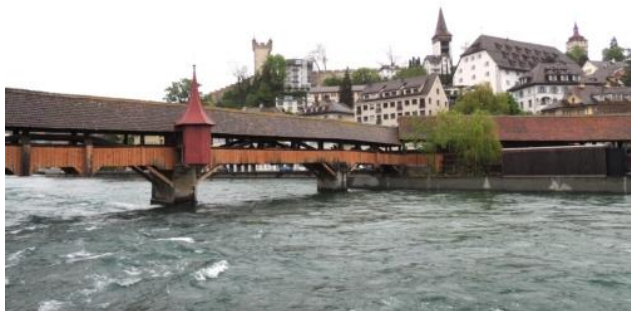
Most Plewny oraz baszty i mury miejskie.
