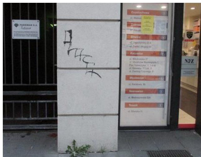
Sąsiadujące z sobą posesje na placu Marii i Lecha Kaczyńskich w Katowicach.
